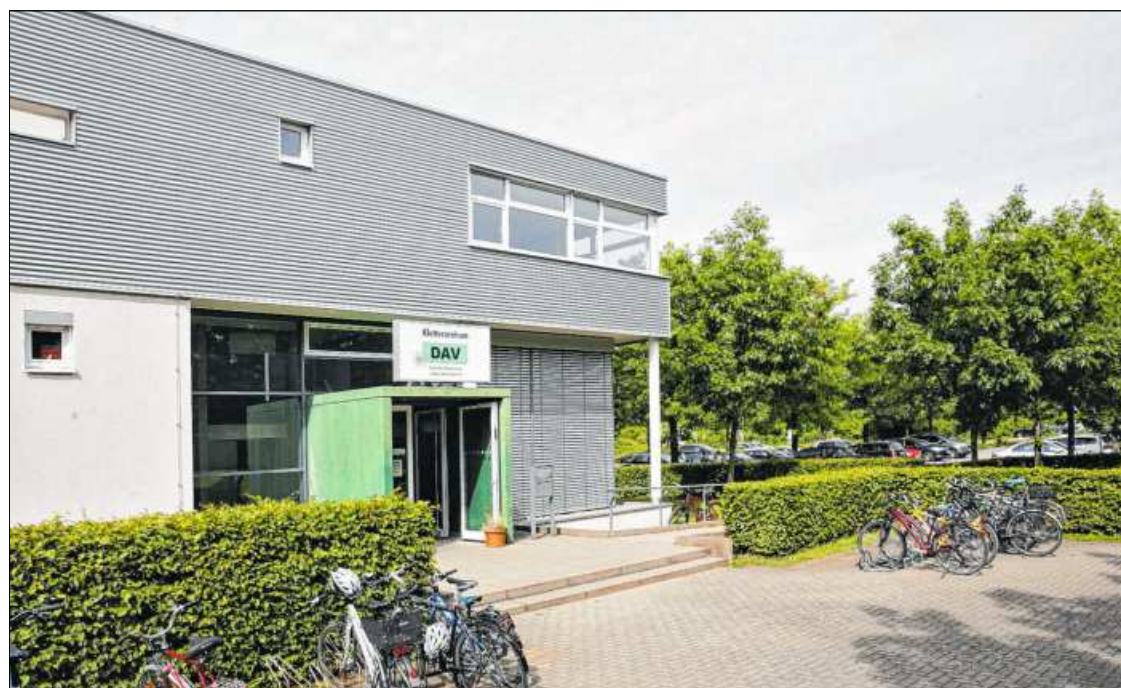
EINEN ANBAU plant der Verein an der Hallenseite beim Parkplatz, direkt angesetzt und in gleicher Höhe. Das Innere wird wie schon das bestehende Gebäude auf allen Ebenen barrierefrei zugänglich.
